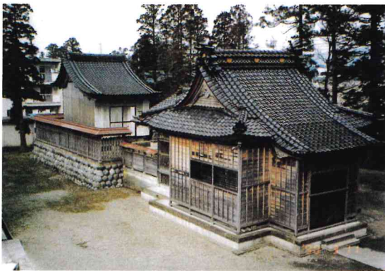
増改築直前の坪野神明宮社殿 平成2年2月
